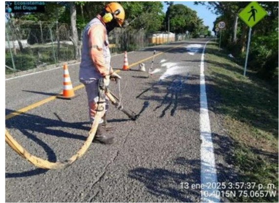
Fotografía 13. Trabajo de selladora de fisuras
