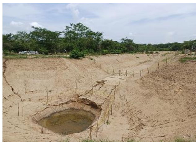
Fotografía 53. Profundidad final de la prueba de excavación.
