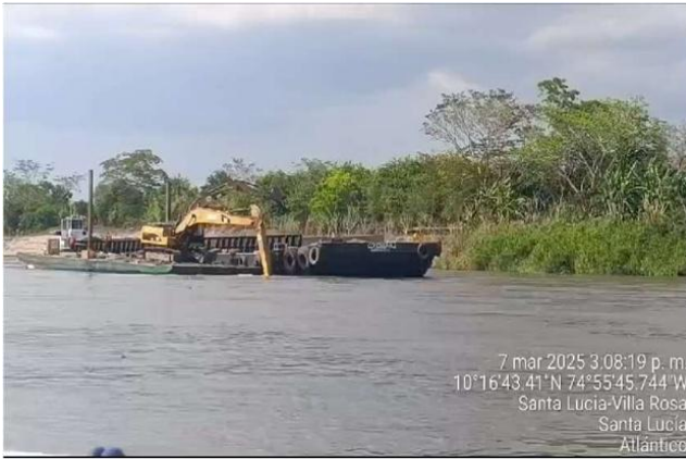
Fotografía 27. Actividades de dragado tramo intermedio
