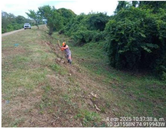
Fotografía 10. Dique protección San Cristóbal
