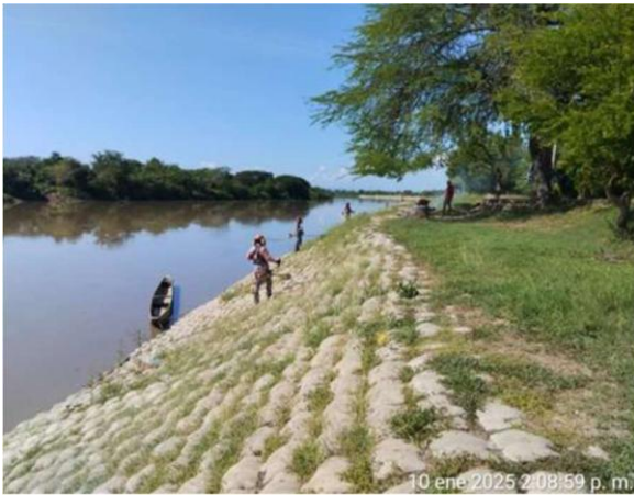
Fotografía 11. Dique protección Santa Lucía.
