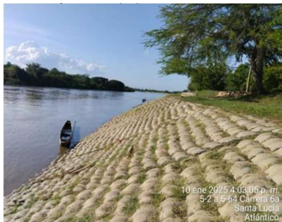
Fotografía 12. Dique protección Santa Lucía UFO
