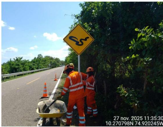
Fotografía 18. Instalación de señales verticales
